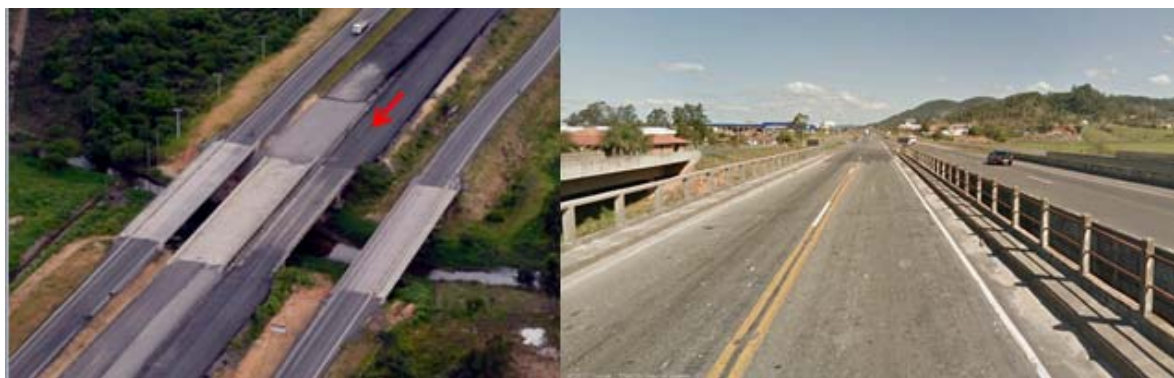
Figura 2 - Ponte sobre o rio Correias
