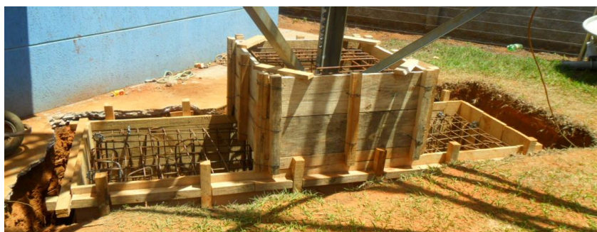
Figura 3 – Reforço pronto para concretagem
