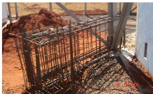
Figura 5 – Armação de viga de reação e reforço concluído
