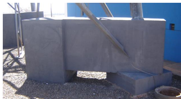
Figura 5 – Armação de viga de reação e reforço concluído
