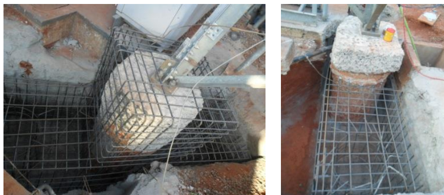
Figura 2 – Armação do bloco de coroamento sobre tubulões de reforço
