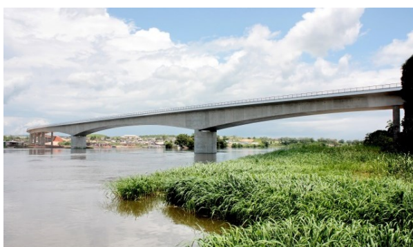
Figura 17 - Ponte e viaduto Norte
