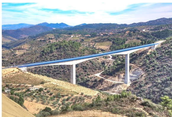
Figura 11 - Nova ponte do Tua
