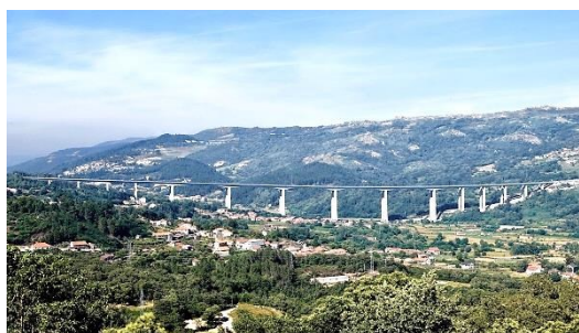
Figura 9 - Viaduto de Vila Pouca
