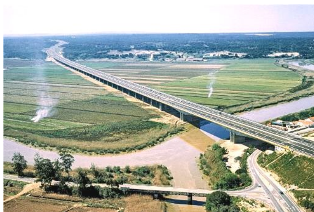
Figura 13 - Ponte do Sado (1997)
