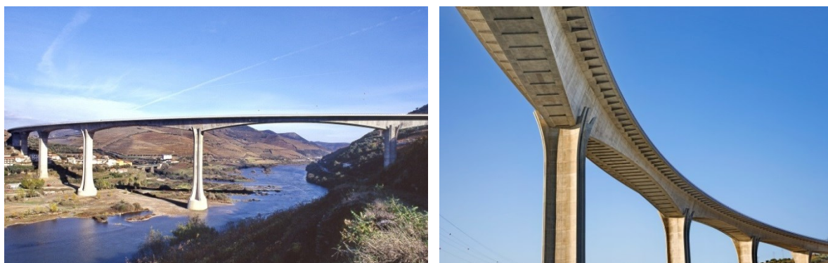
Figura 5 - Ponte Miguel Torga - Régua (1997)
