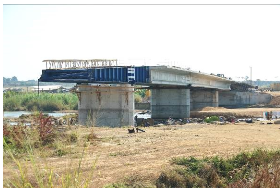
Figura 22 - Lançamento de um tabuleiro
