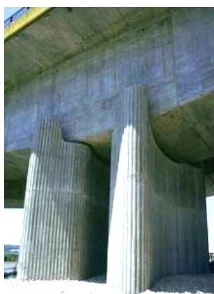
Figura 14 - Fundações estaca/pilar da ponte e do viaduto de acesso
