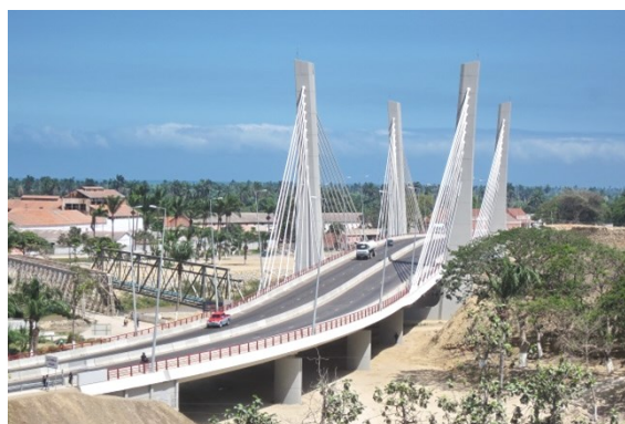
Figura 32 - Vista de Sul
