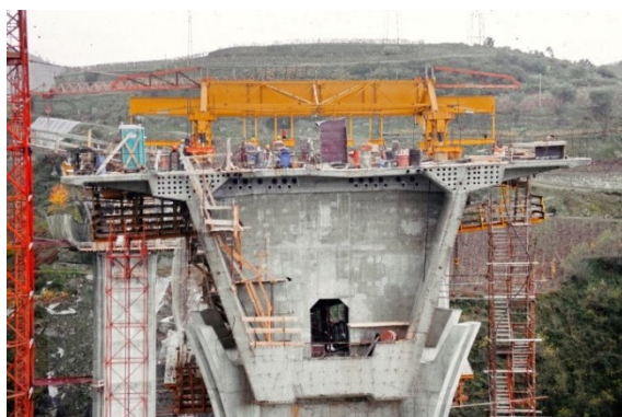
Figura 7 - Ponte Miguel Torga - Pré-esforço do tabuleiro – arrumação dos cabos
