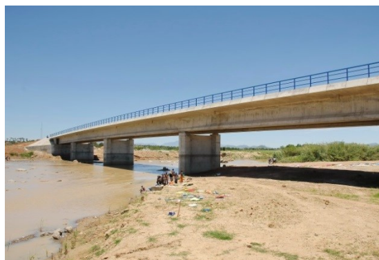
Figura 24 - Vista geral de uma das pontes
