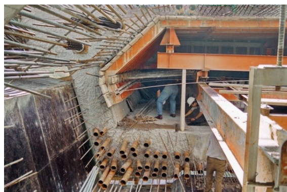
Figura 7 - Ponte Miguel Torga - Pré-esforço do tabuleiro – arrumação dos cabos
