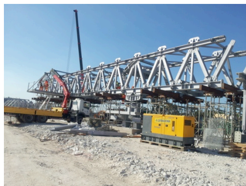
Figura 5.1 – Montagem do equipamento
