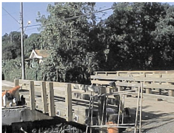
Figura 2 – Ponte sobre o Rio Monjolinho-SP.
