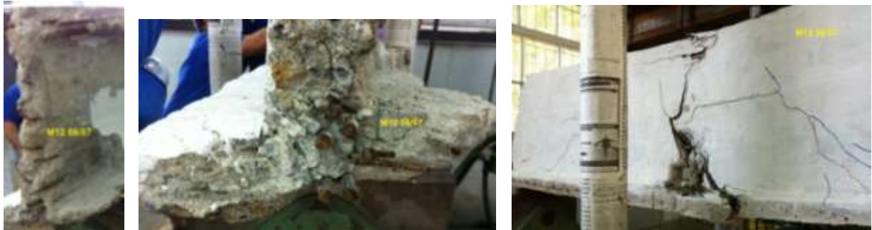
Figura 3: Fotos da seção transversal e da fissuração de ruptura da viga M12 56/57.
