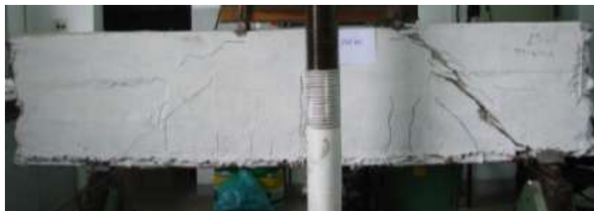
Figura 2: Fissuração de ruptura da viga M4 16/17A.
