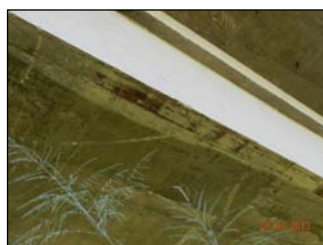
(b) Deslocamento entre a pista de rolamento da rodovia e da ponte.
