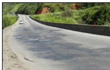
(a) Serviços tapa buraco na pista lado direito da ponte (figura 1).
