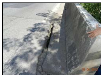
(b) Deslocamento entre a pista de rolamento da rodovia e da ponte.
