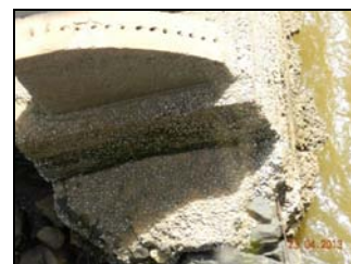
(c) Vista superior do bloco do pilar P3: erosão e armaduras expostas.
