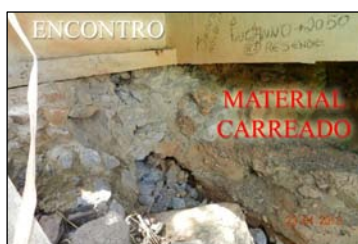
(d) Movimentação do material do encontro e degrau no aterro compactado.
