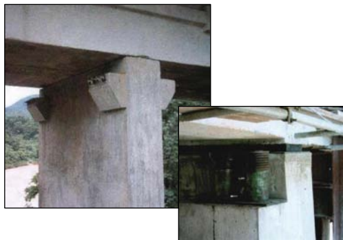
Figura 4 – Obra de reforço: detalhes do reforço dos pilares P1 e P2.
