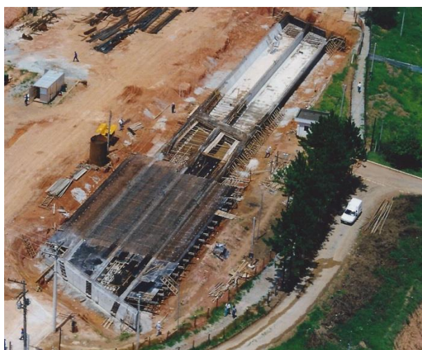
Figura 2 - Imagem de obra no Rodoanel Oeste – alternativa em caixão perdido.
