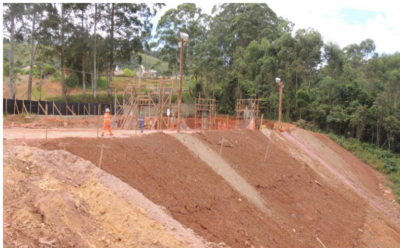
Figura 12 - Obra 422 para alternativa em vigas caixão – Execução.
