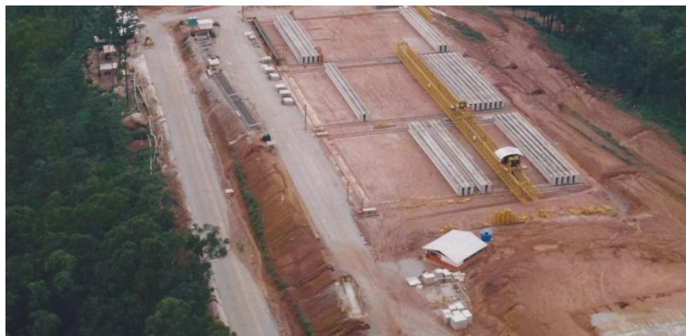
Figura 1 – Imagem de obra no Rodoanel Oeste – alternativa em vigas pré-moldadas.
