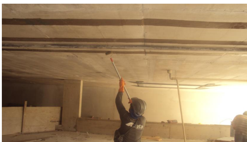
Figura 1: Aplicação do imprimador Viapol Carbon Primer
