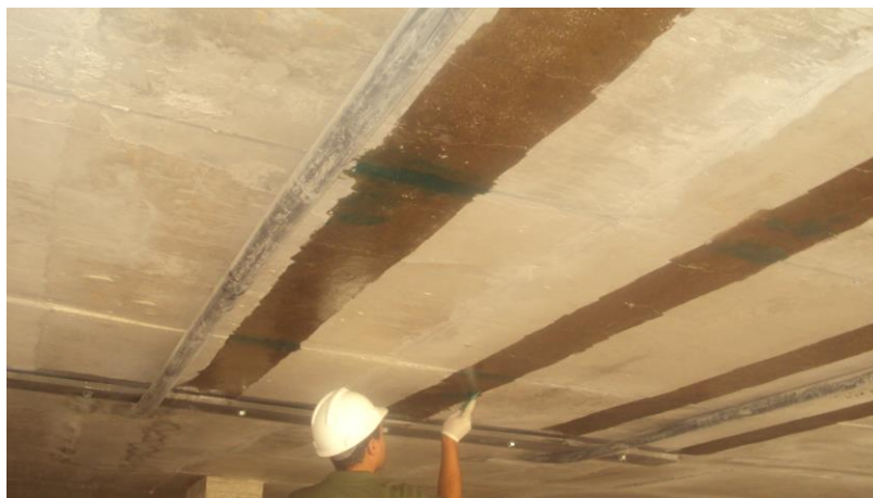
Figura 2: Aplicação do Viapol Carbon Stuc
