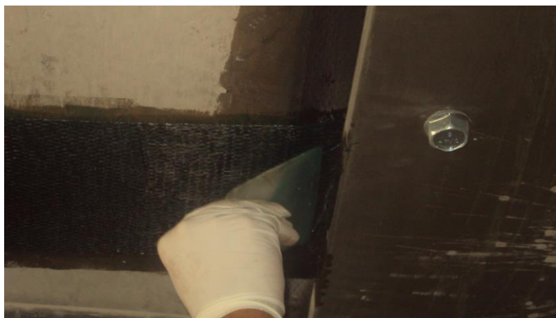
Figura 6: Reforço da aplicação de resina saturante nas extremidades do sistema
