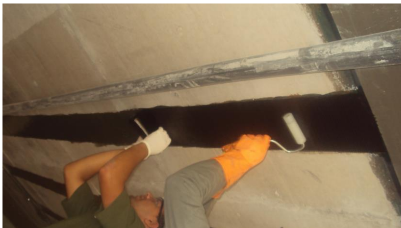
Figura 4: Aplicação do tecido de fibra de carbono Viapol Carbon CFW300
