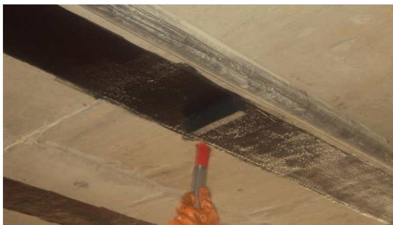
Figura 5: Aplicação da segunda camada de resina saturante Viapol Carbon Saturante
