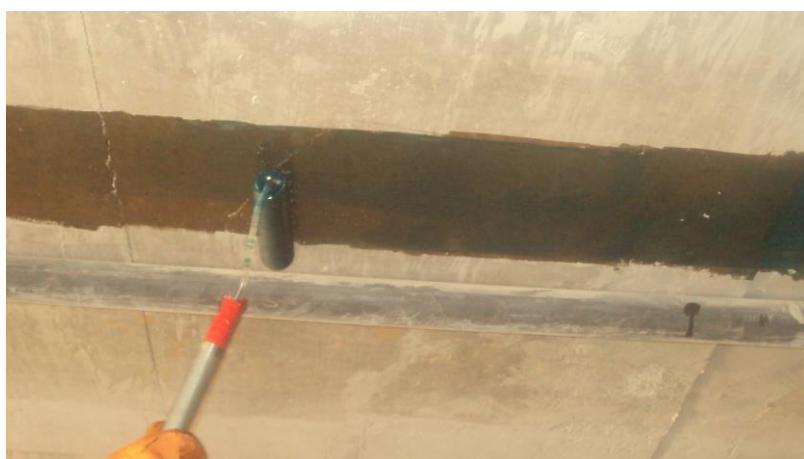
Figura 3: Aplicação do saturante Viapol Carbon Saturante
