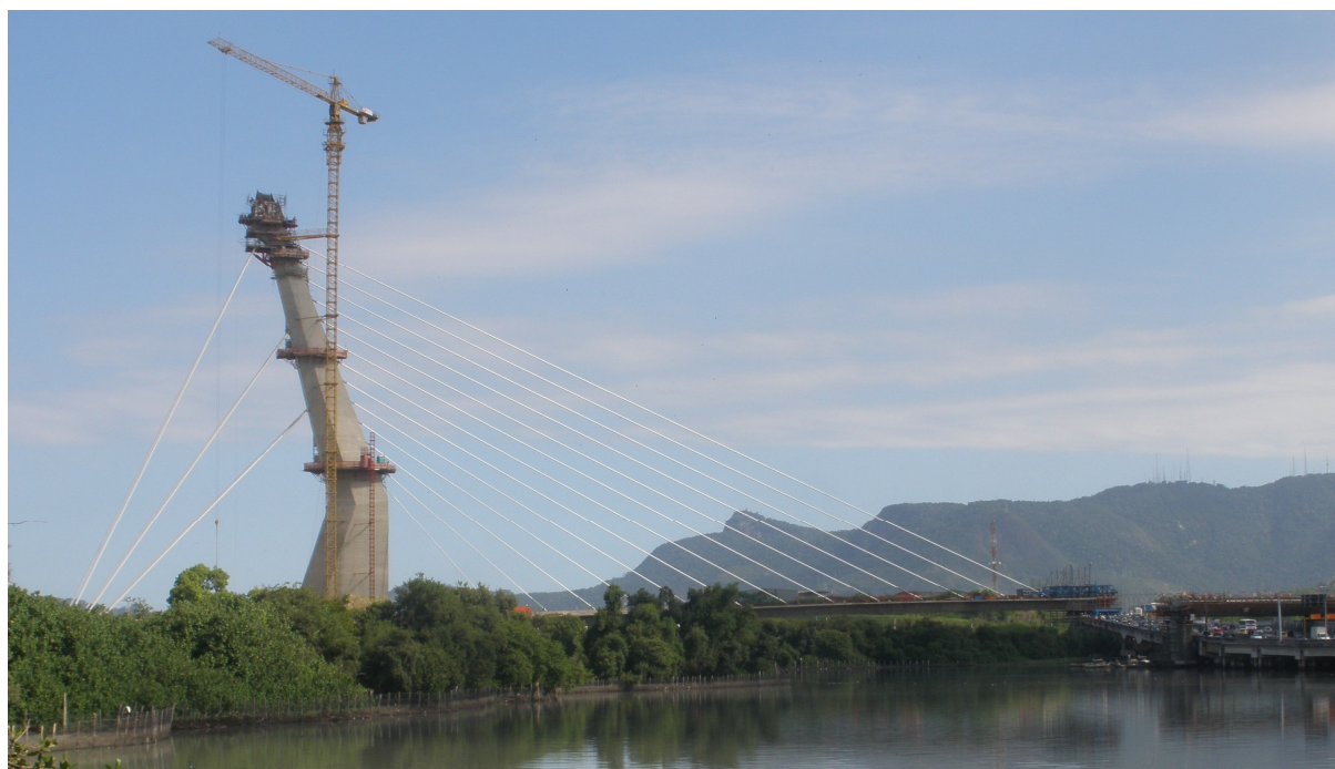
Figura 1 – Vista lateral da Ponte do Saber em construção
