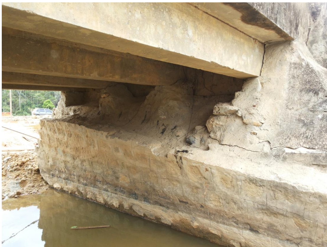
Figura 5 – Face inferior do tabuleiro
