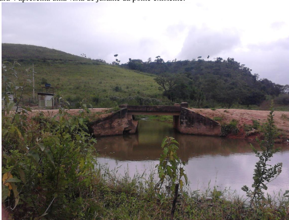
Figura 4 – Vista de jusante da ponte
