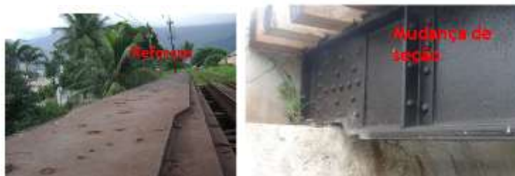
Figura 5 - Elementos com alta concentração de tensões
