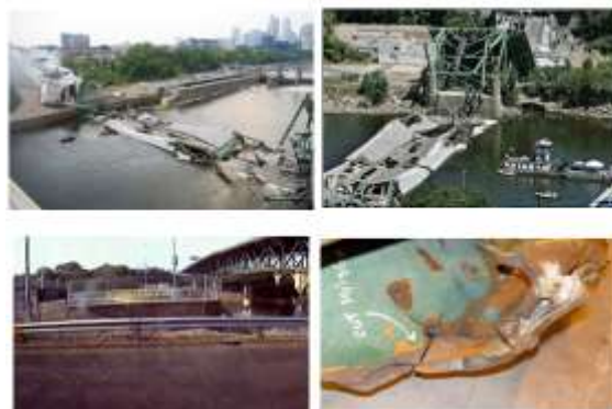
Figura 1 - Colapso da Ponte I-35W, Mississippi
