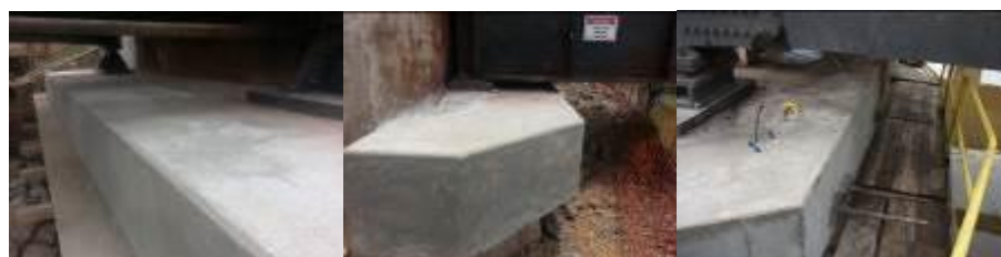
Figura 5: Trabalhos de adequação e reforço dos encontros e pilar
