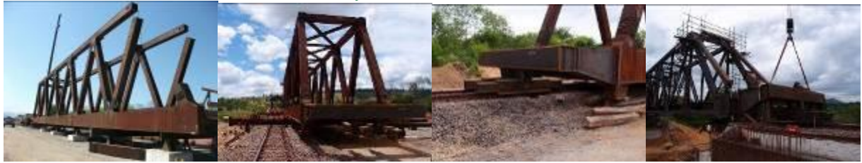
Figura 2: Trabalhos de montagem e substituição da ponte
