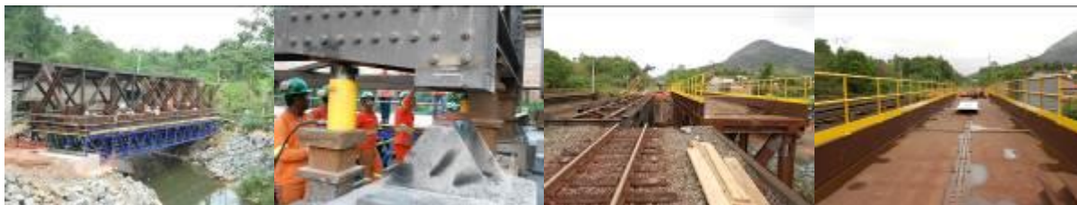
Figura 13: Trabalhos de montagem e substituição das pontes.
