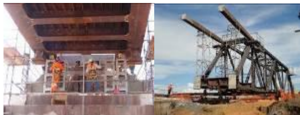
Figura 4: Trabalhos de substituição da ponte
