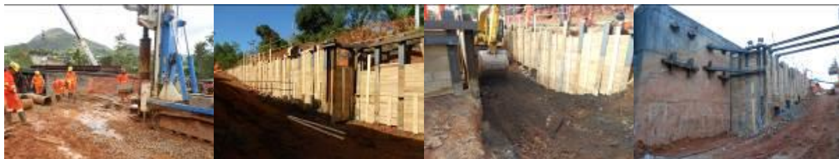
Figura 12: Trabalhos de execução de contenção provisória entre vias.
