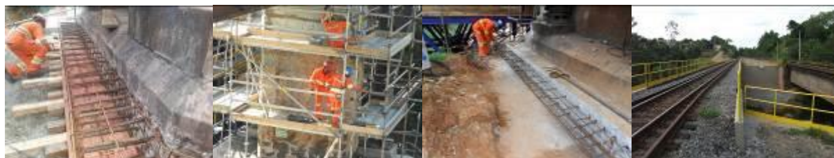
Figura 10: Trabalhos de reforço e adequação dos encontros e pilar e muro de suporte
