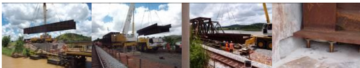
Figura 9: Trabalhos de remoção e colocação de novo vão de 16m
