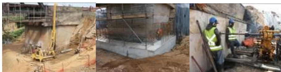
Figura 1: Trabalhos de adequação e reforço dos encontros
