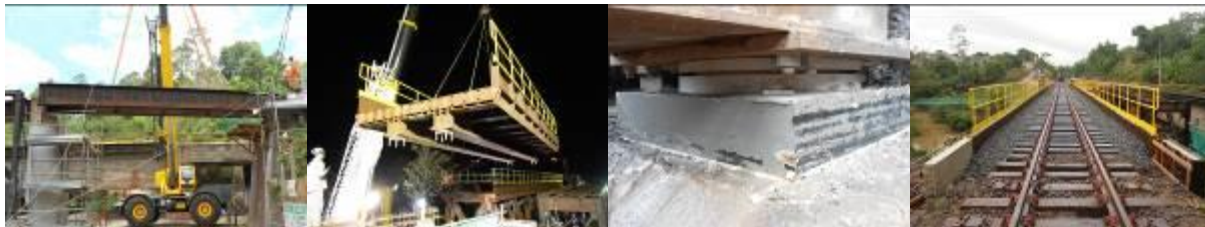
Figura 14: Trabalhos de substituição das pontes.
