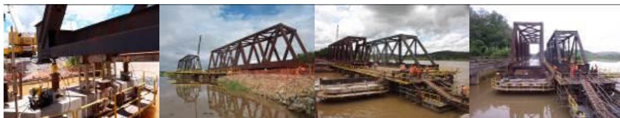
Figura 7: Trabalhos de elevação dos tabuleiros e movimentação das pontes
