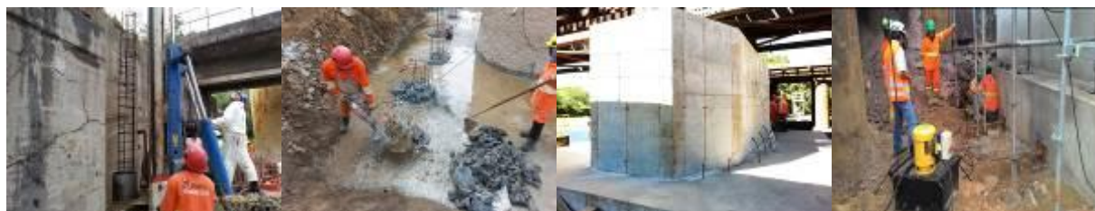
Figura 15: Trabalhos de adequação e reforço dos encontros e pilar.
