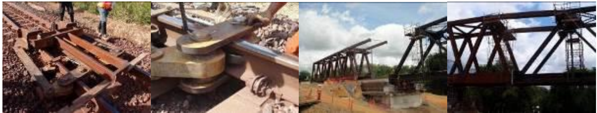
Figura 3: Trabalhos de substituição da ponte
