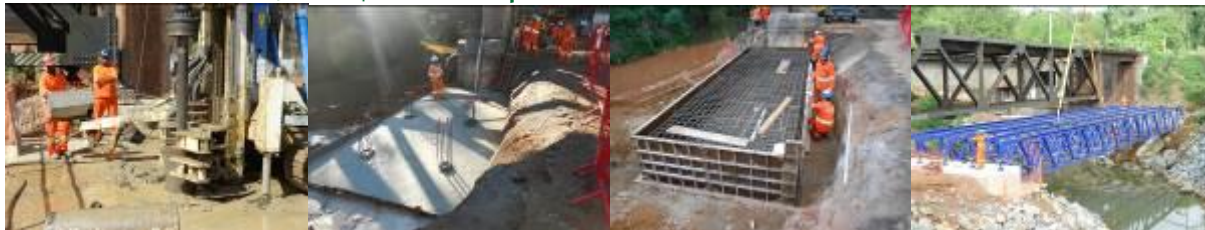
Figura 11: Trabalhos de execução de plataformas de montagem e desmontagem
