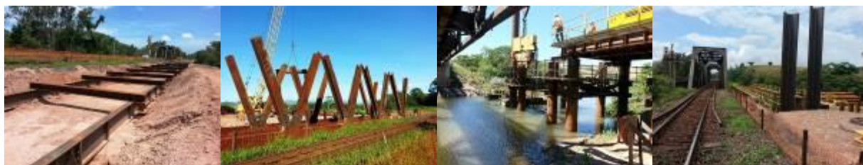
Figura 16: Trabalhos de montagem da ponte, do jetty e contenção provisória do encontro.
