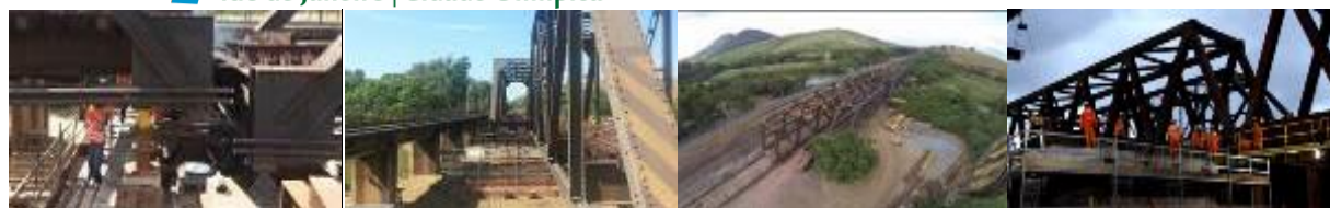
Figura 17: Trabalhos de elevação dos tabuleiros e movimentação das pontes
