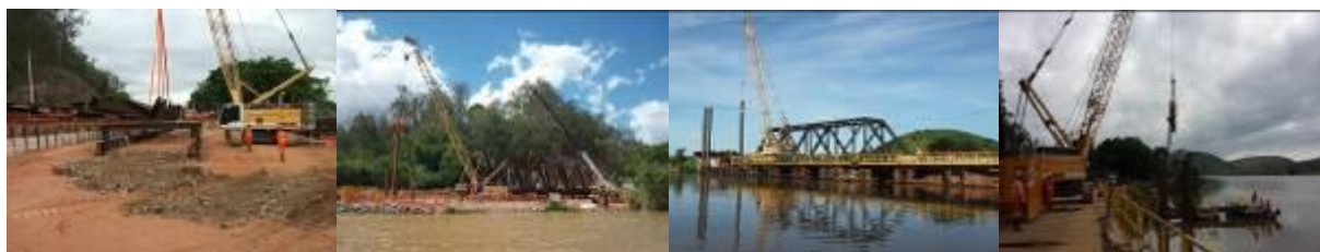
Figura 6: Trabalhos de montagem da ponte e do jetty
