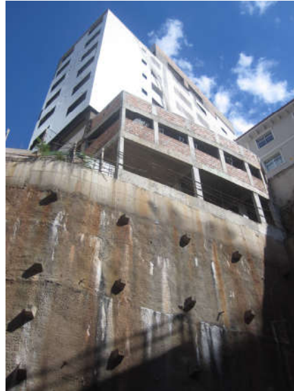
Figura 11 – Vista da edificação após recuperação
