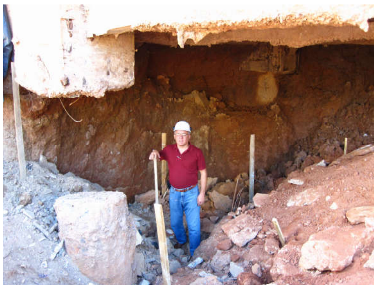
Figura 3 – Vista do tubulão e bloco (suspenso)
