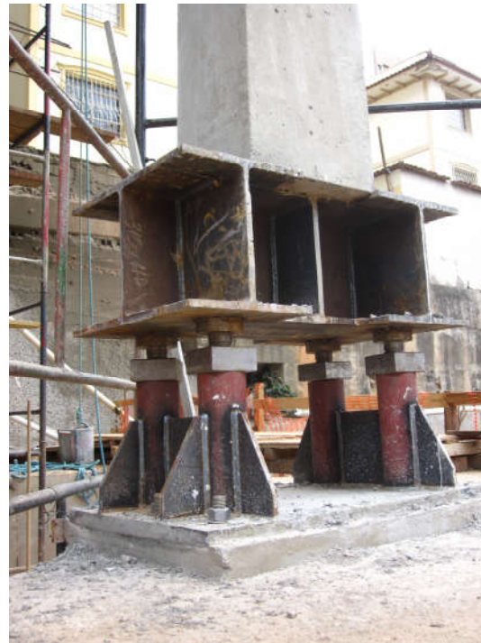
Figura 7 – Vista do pilar concretado
