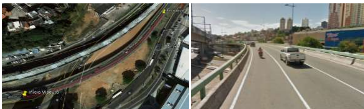
Figura 5 – Vista aérea do viaduto (esquerda) e vista do tabuleiro do viaduto (direita) (fonte: Autor 2013)
