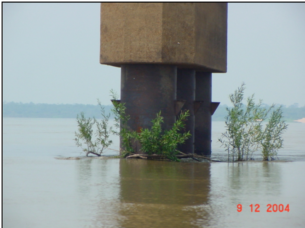
Figura 3. Vegetação ao redor de tubulão de ponte no rio Tocantins, Pará, Brasil.
