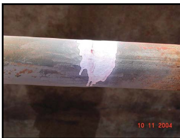
Figura 4. Aplicação do revelador em barra metálica de ponte no Pará, Brasil.
