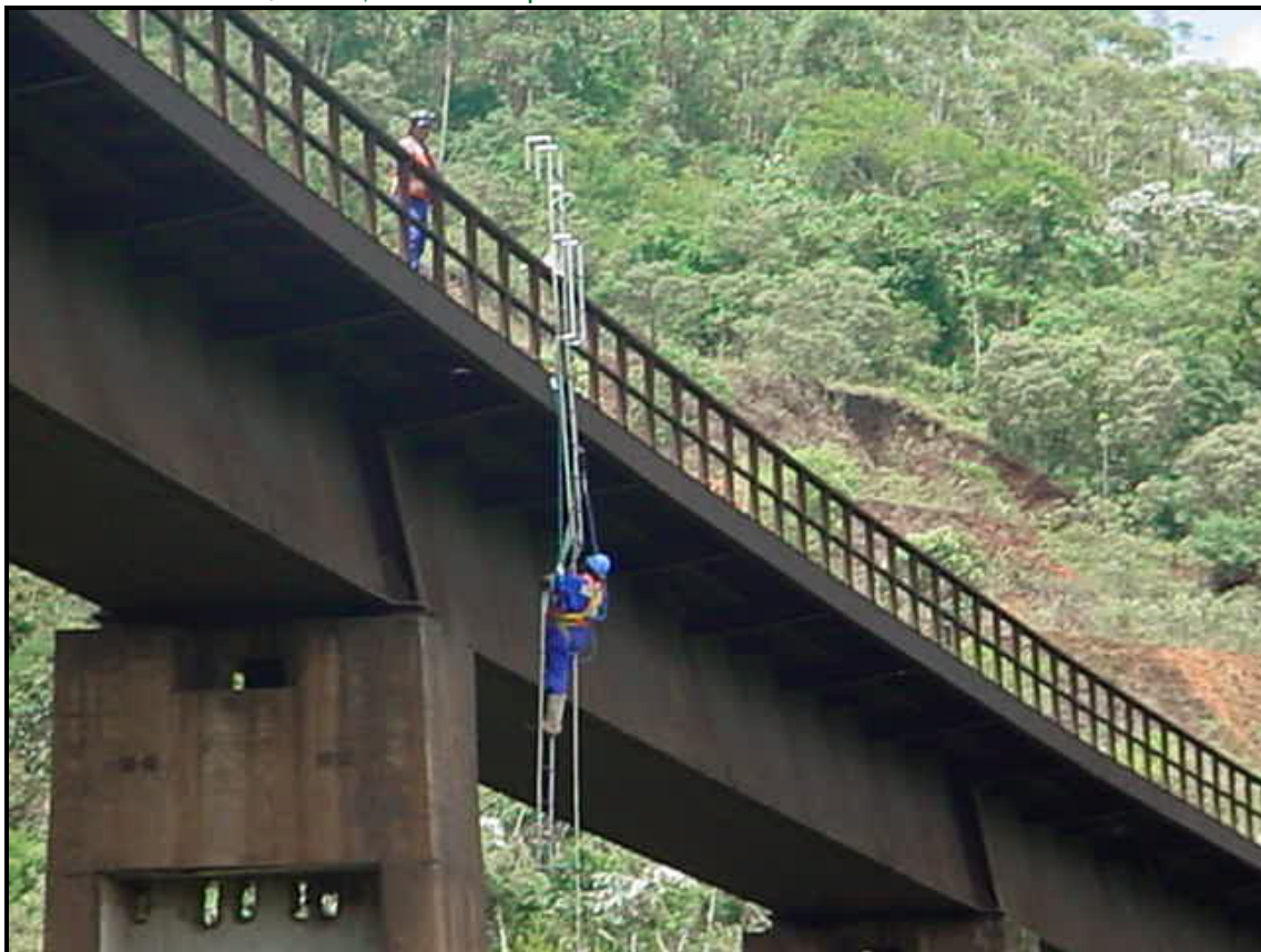
Figura 1. Ponte sobre o Córrego do Ouro, em Minas Gerais, Brasil, com os pilares em concreto armado e tabuleiro em estrutura metálica sobre um ecossistema fechado.
