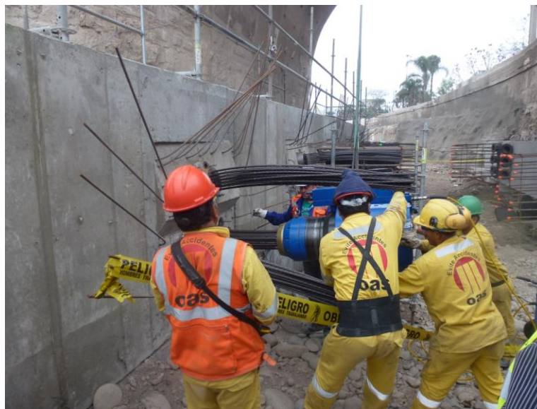
Figura 5. Pretensado de las vigas transversales de apeo
