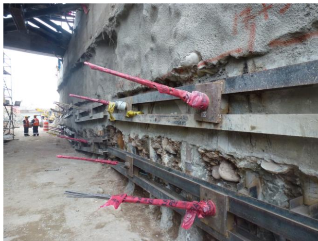
Figura 4. Pantalla de micropilotes de contención lateral
