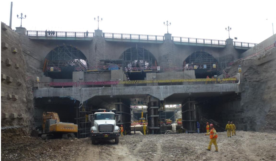
Figura 7. Puente de Trujillo apeado sobre micropilotes
