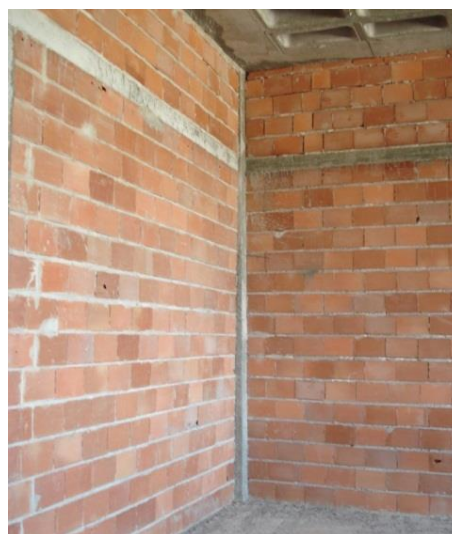
Figura 4 – Foto do pilar em estudo sem o revestimento.
