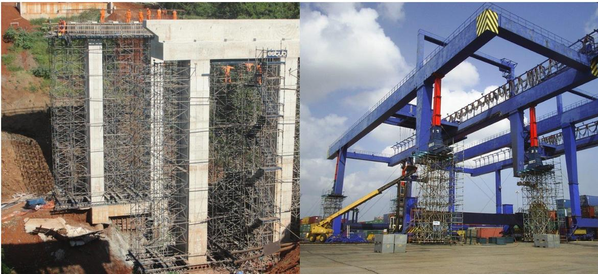
**Figura 1 – Escoramento de um viaduto (esquerda) e de uma estrutura de aço (direita).**
