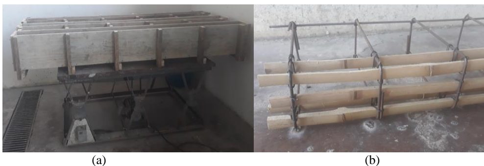
Figura 5: Confeção das vigas – (a) formas posicionadas sobre a mesa vibratória; (b) detalhe da armadura com bambu
