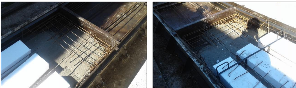
Figura 3 – Interrupção do EPS na extremidade da laje alveolar produzida com fôrma fixa.
