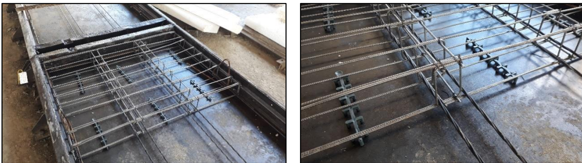
Figura 2 – Detalhe do posicionamento da armadura transversal.
