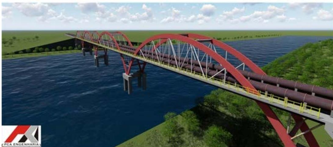
**Figura 1 – Ponte metálica em arcos para a um sistema de adutoras e com uso conjunto de passarela de pedestre.**
