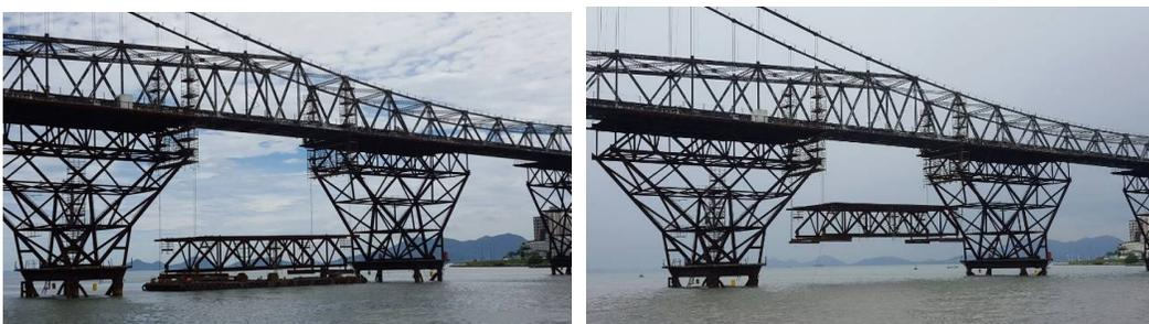
**Fig. 12: Montagem das treliças intermediárias da estrutura auxiliar.**
