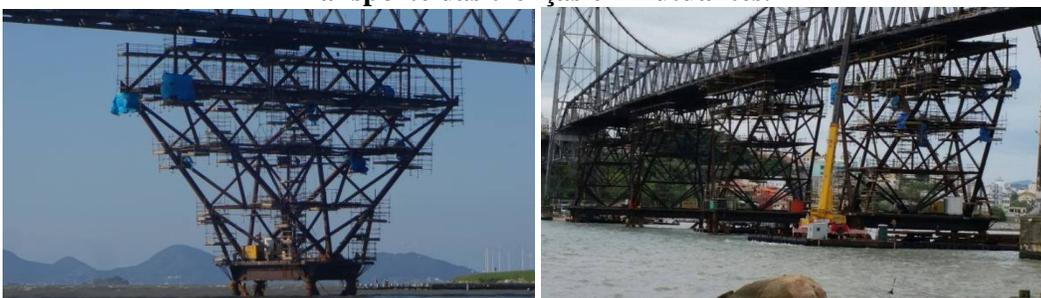
**Fig. 11: Montagem das torres da estrutura auxiliar.**
