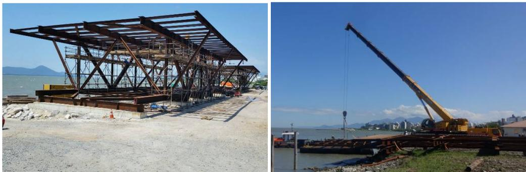
**Fig. 10: (a) Pré-montagem da treliça da estrutura auxiliar no canteiro (b) Transporte das treliças em flutuantes.**
