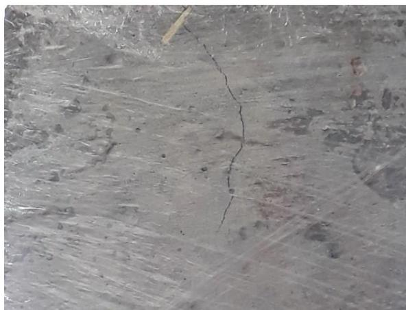
**Figura 6:** Pilar reforçado com fissura
