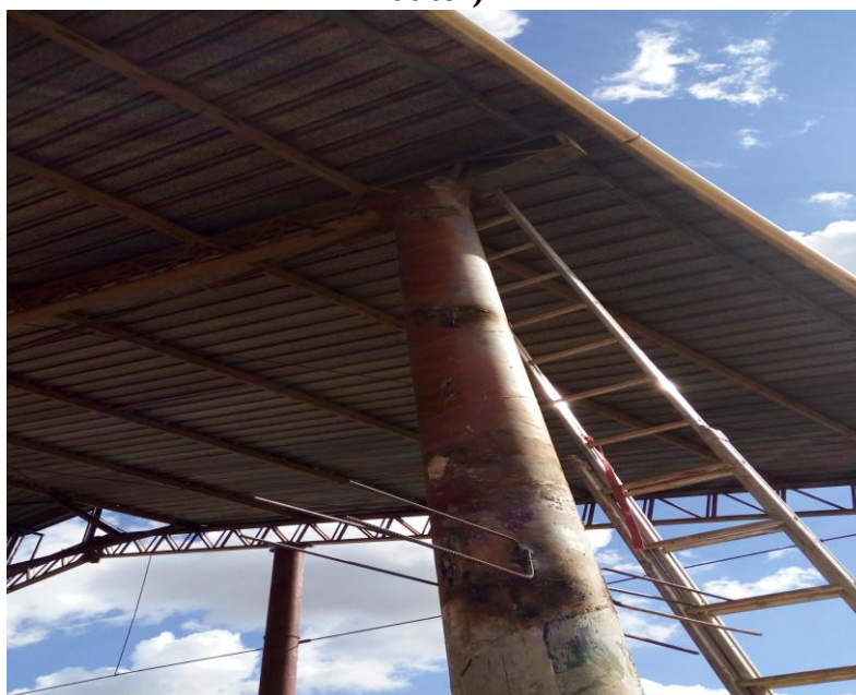
Figura 9 – Detalhe do pilar metálico com carepa de laminação e pites (Fonte: autor)
