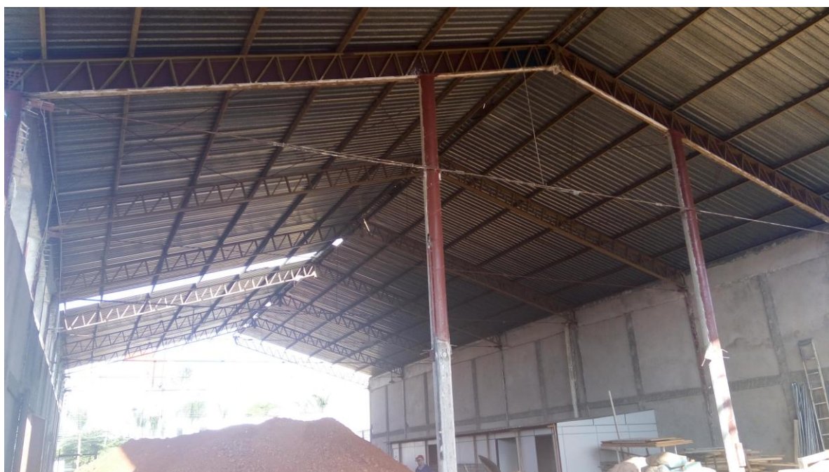
Figura 3 – Vista da edificação avaliada (Fonte: autor)
