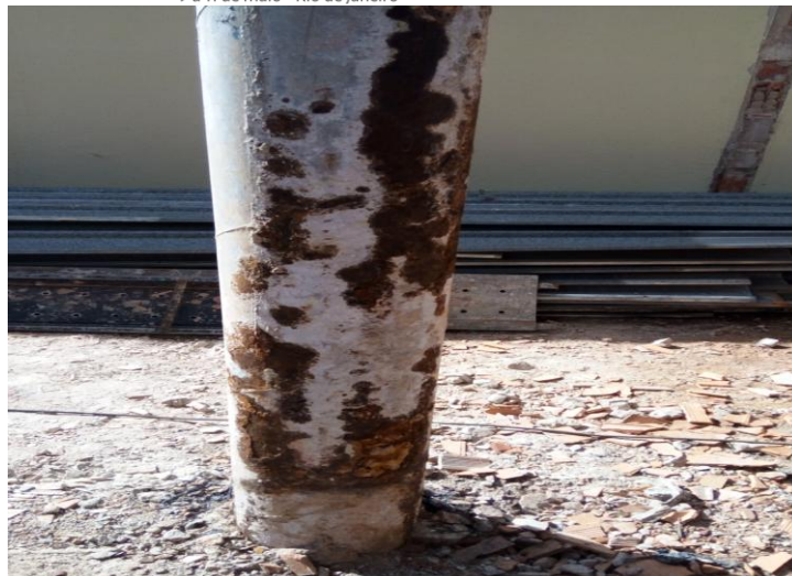
Figura 9 – Detalhe do pilar metálico com carepa de laminação e pites (Fonte: autor)
