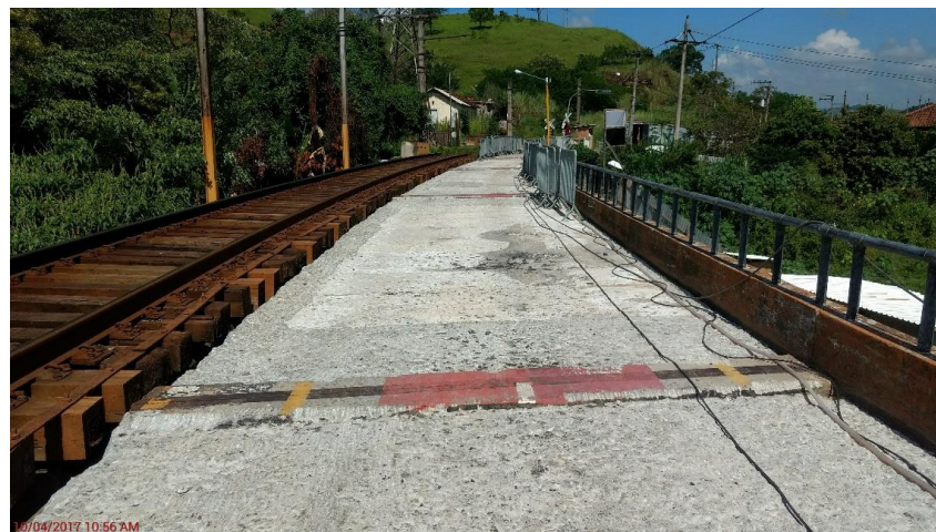
Figura 10 – Tabuleiro da Ponte e junta de dilatação
