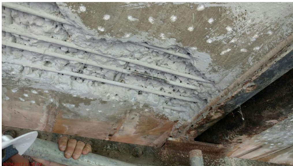
Figura 12 – Tabuleiro da Ponte (face inferior com tratamento em execução)
