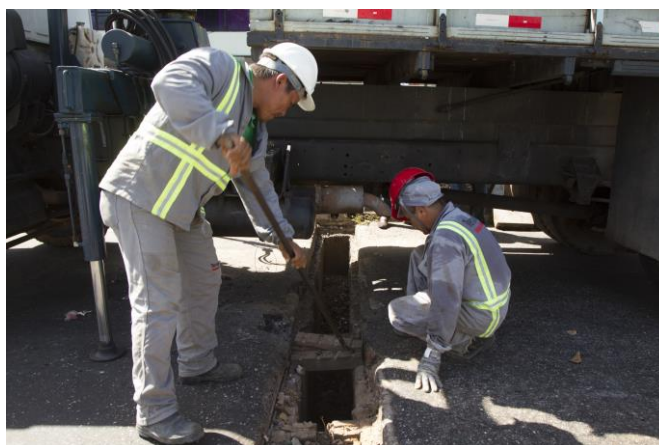
Figura 04 – Reparos na Estrutura (Fonte: Divulgação)
