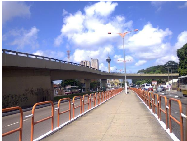
Figura 01 – Vista Geral do Viaduto (Fonte: Divulgação)
