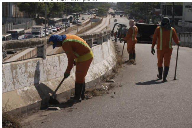
Figura 03 – Reparos na Estrutura (Fonte: Divulgação)
