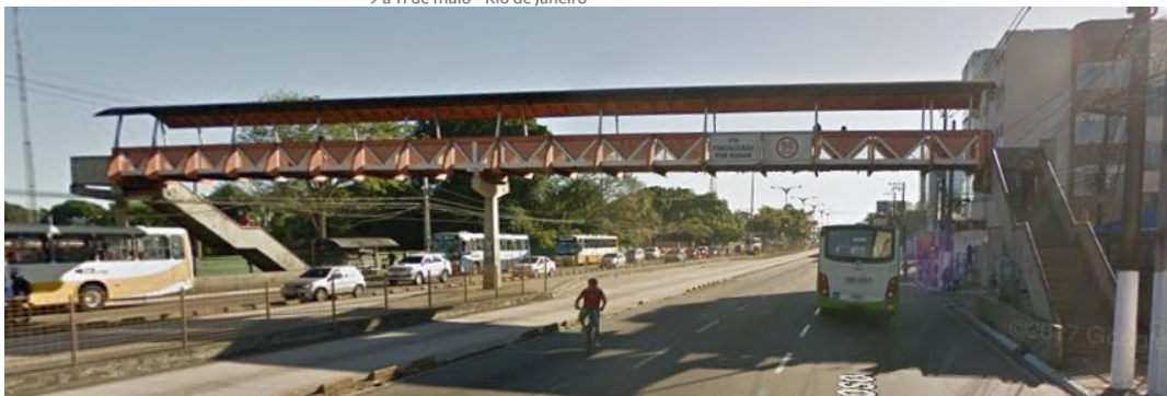
Figura 2 – Passarela analisada (Fonte: Google Earth).
