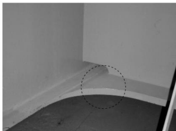
Figura 5 – Exemplo da ligação soldada entre flange inferior e chapa Gusset . Fonte: Figueiredo (2007).
