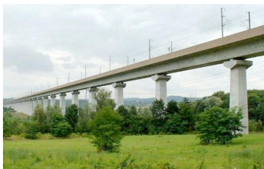
Figura 1 – Ponte de alta velocidade.
