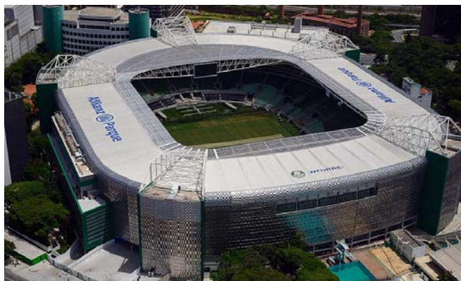
Figura 11 – Imagem aérea da arena concluída
