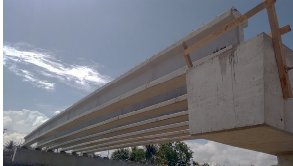
Figura 4 –Obra em fase de montagem. Ponte sobre o Rio Maranguapinho/Fortaleza/CE vão de 20m intereixo de 1m.
