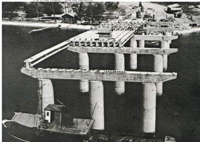
Figura 1 – Foto da construção da ponte do galeão.
