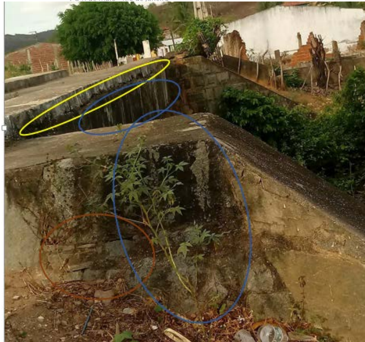
Figura 3 – Vista Frontal da Estrutura Fonte: Autores (2018)
