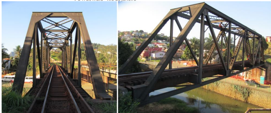
Figura 1 – Vistas gerais da ponte sobre o Rio Fundão.
