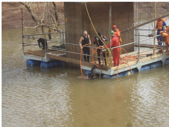
Figura 12 – Posicionamento das fôrmas por mergulhadores
