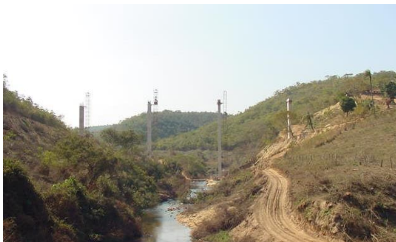
Figura 1 - Vista de fase construtiva da ponte sobre o rio Ventania
