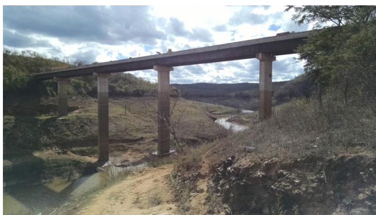
Figura 2 - Vista lateral da ponte sobre o rio Ventania
