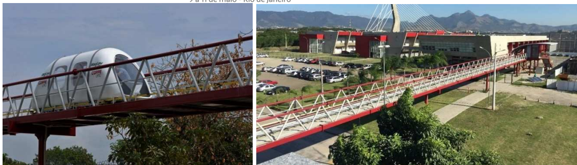
Figura 3 – MAGLEV-COBRA (SML) trafegando e a via elevada do Campus da UFRJ
