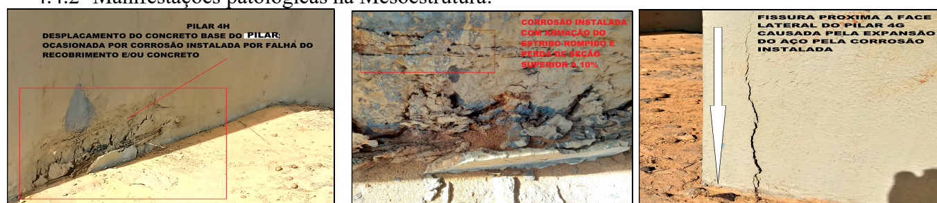
Figura 13 – Manifestações patológicas na mesoestrutura (Acervo dos autores (2020)).
