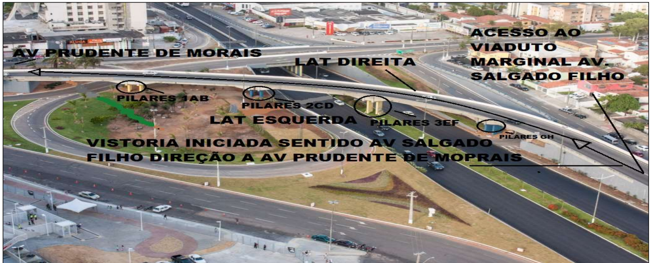
Figura 1 – Detalhamento da Estrutura do Viaduto Quarto Centenário de Natal/RN (Acervo dos autores (2020)).
