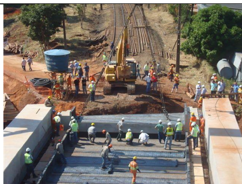
Figura 15 – Impermeabilização de Viaduto ferreo (FERROBAN) com Manta asfáltica (Imagem Viapol)
