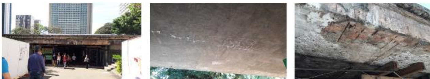
Figura 3 - Galeria dos Estados-Estrutura sob Passeio de Concreto /Brasília – 2018 (Acervo do autor)
