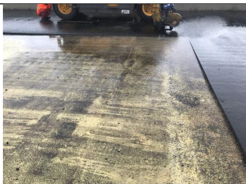
Figura 14 – Aplicação de capeamento asfáltico sobre impermeabilização a base de poliuréia (imagem Sika)
