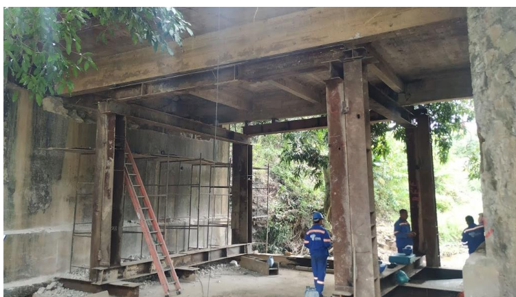
Figura 9 – Execução da obra de recuperação da ponte.
