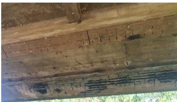
Figura 4 – Armaduras expostas e corroídas.
