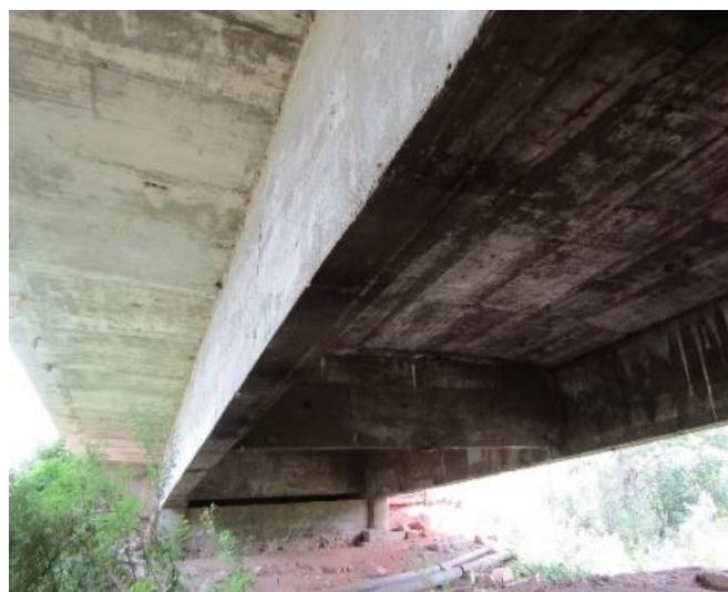
Figura 3 – Vista geral inferior.
