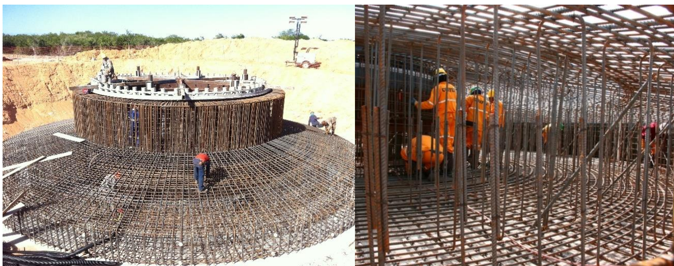
Figura 3 – Montagem das armaduras de uma fundação de aerogeradores
