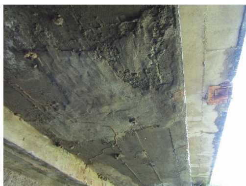
Figura 8 – Nincho de concretagem (Fonte: SGO, 2019).
