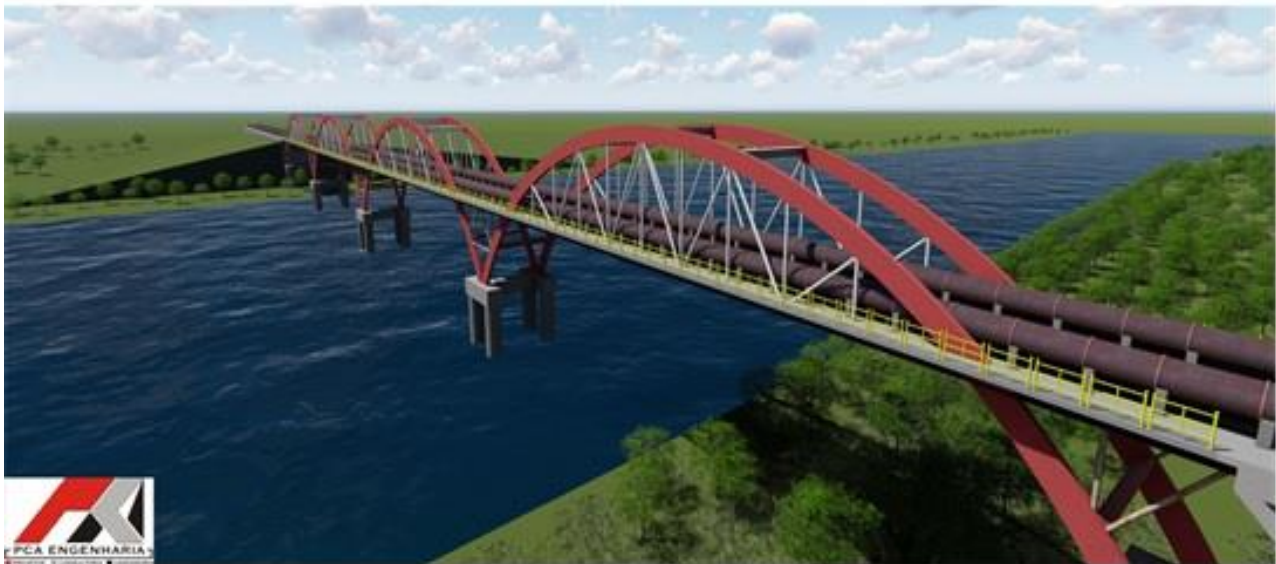
Figura 1 – Ponte mista em arcos metálica para a um sistema de adutoras e de uso como passarela.
