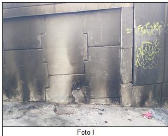
Figura 8 - Contenção em terra armada danificada (Autores).
