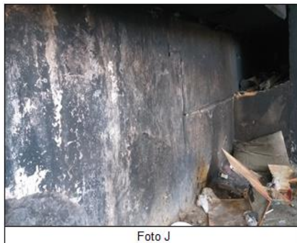
Figura 8 - Contenção em terra armada danificada (Autores).
