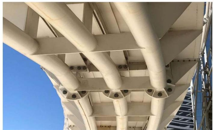
b) Detalhe das longarinas e transversinas metálicas
