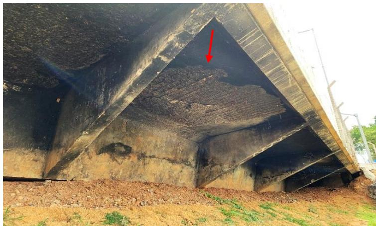
**Figura 2 - Deterioração do Concreto em Laje em Balanço por parte da ação pontual do fogo em uma OAE Urbana.**
