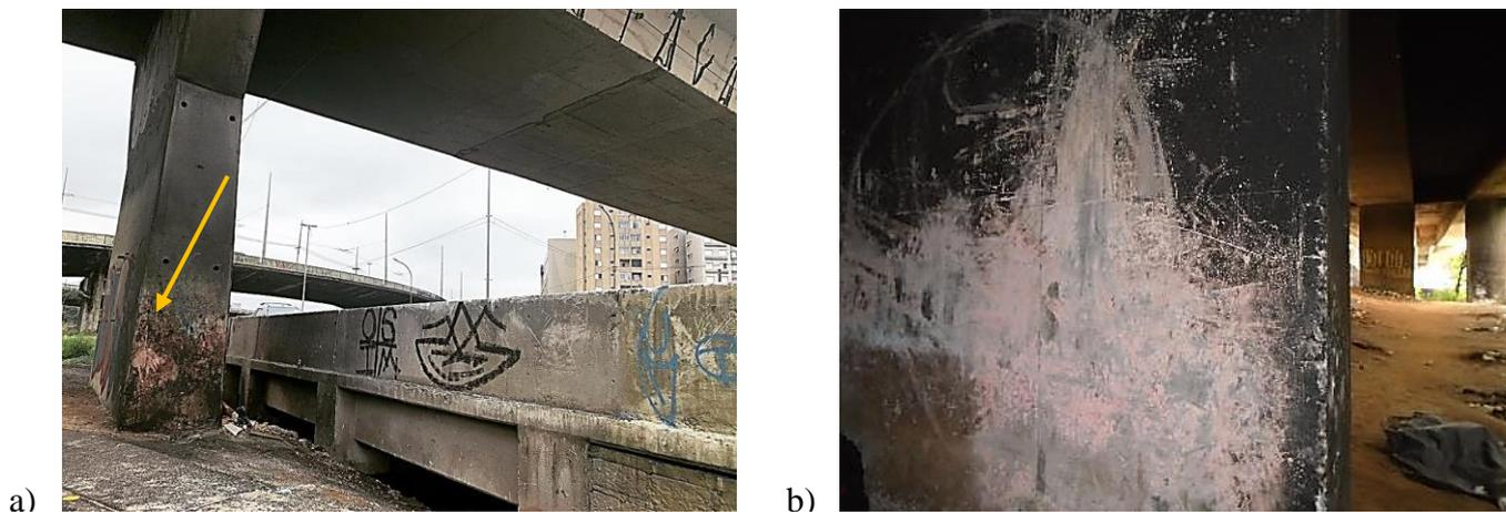
**Figura 7 – Diferentes pilares acometidos pelo Fogo em ação Pontual em (A) Viaduto sobre a Av. do Estado e na (B) Av. Interlagos**
