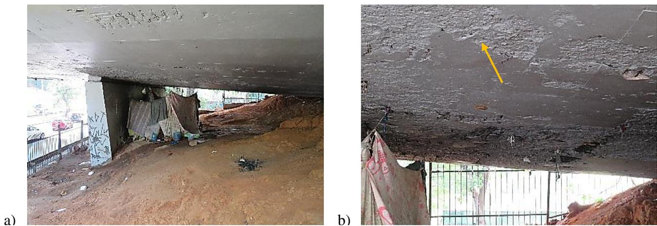
**Figura 6 - Laje Inferior de Ponte Acometida pelo fogo em ação pontual na Av. Bandeirantes**
