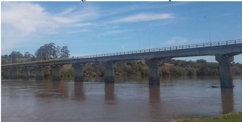
Figura 1-a) Vista longitudinal da ponte existente
