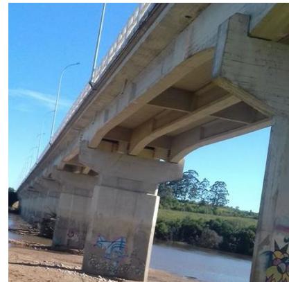
Figura 1-b) Vista inferior da ponte existente
