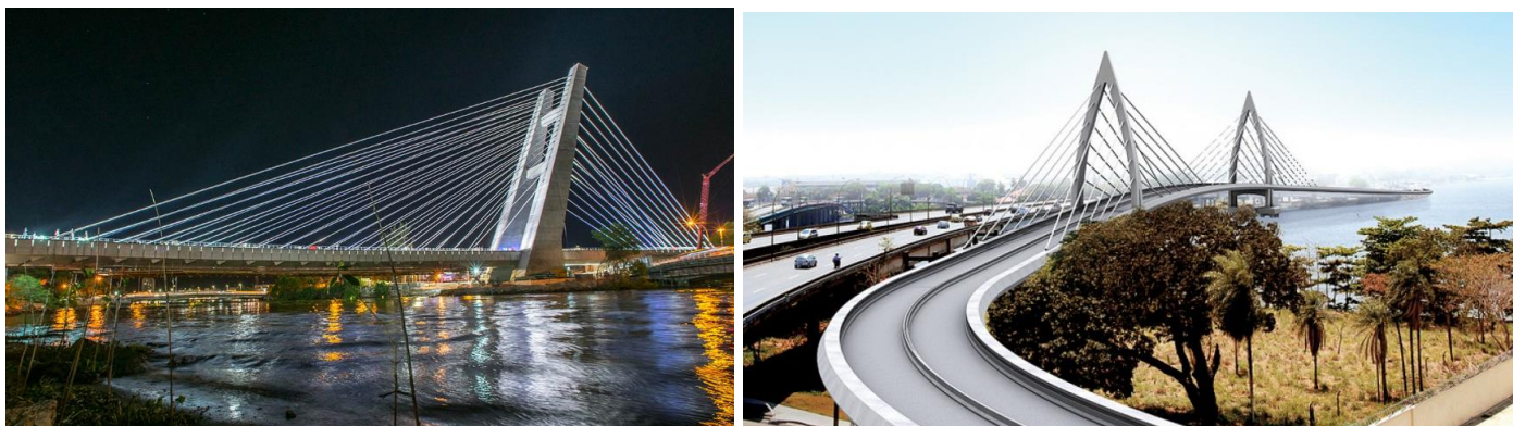
Figura 2 - Ponte Metroviária da Barra e Ponte do BRT na Ilha do Governador.
