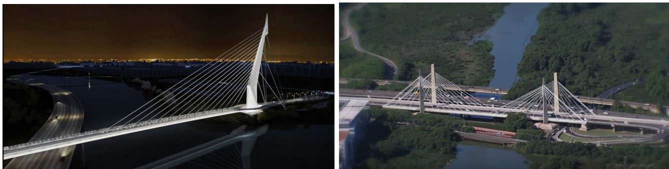
Figura 1 - Ponte do Saber e Ponte D. Eugenio de Araujo Sales.
