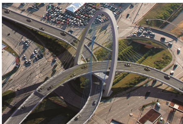
Figura 3 - Viaduto Arco da Inovação em São Jose dos Campos.
