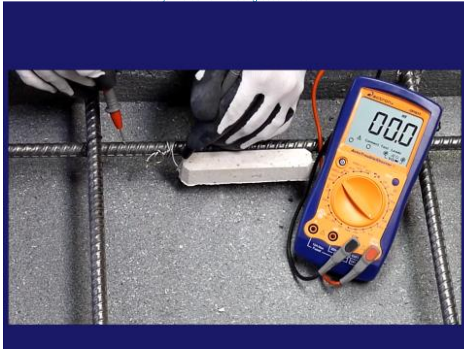
Fig. 1: Instalação de Anodo de Proteção Catódica para a Proteção Contra a Corrosão de Armadura de Aço de Estrutura de Concreto ou Cabos Pré-Tensionados
