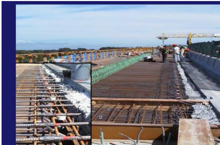
Fig. 2: Anodos de Proteção Catódica em Fase de Instalação
