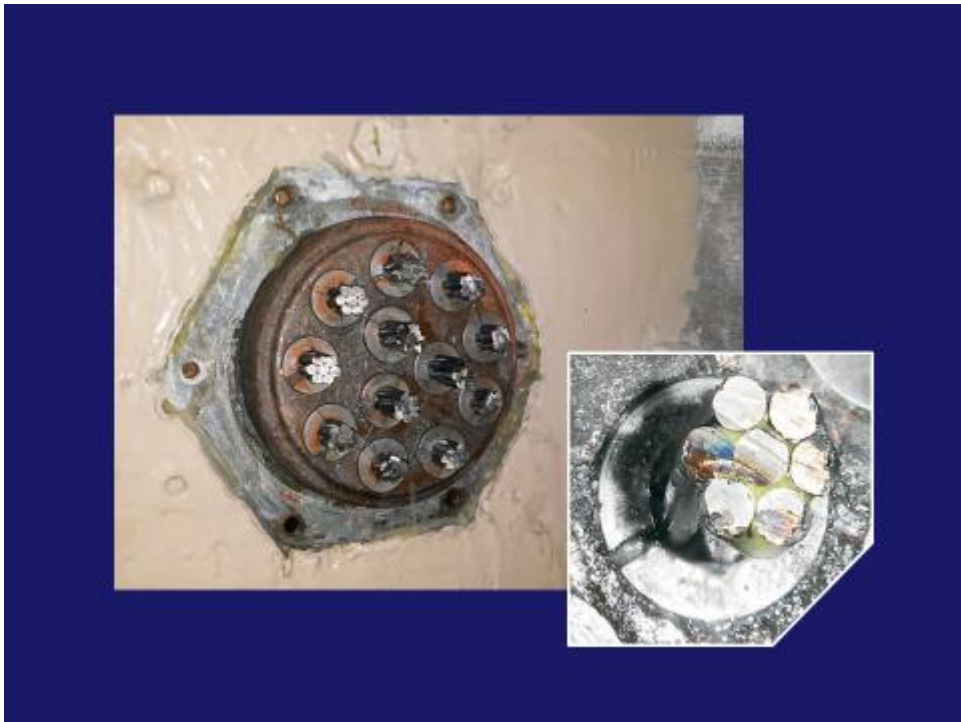
Fig. 8 Fluido de Impregnação Saindo na Extremidade Oposta do Cabo Pós-Tensionado
