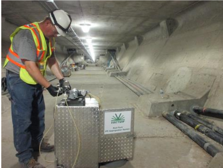
Fig. Serviços de Investigação dos Problemas de Corrosão em Cabos Pós-Tensionados
