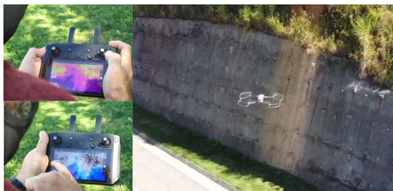
Imagem de Inspeção com Drone de Cortina Atirantada com imagem termográfica
