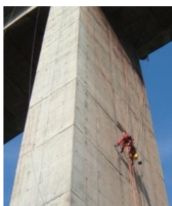
Figura 1 - Inspeção de OAE por Rapel
