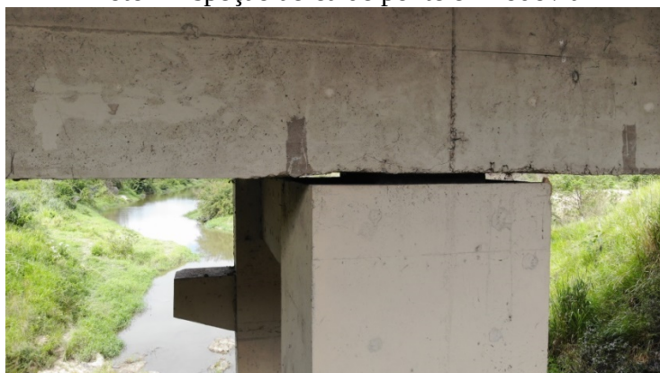
Foto – Inspeção Visual de Aparelho de Apoio em ponto de acesso difícil (altura)
