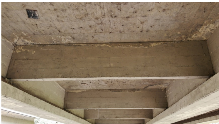
Foto - Inspeção Visual parte inferior da laje de acesso difícil (altura)
