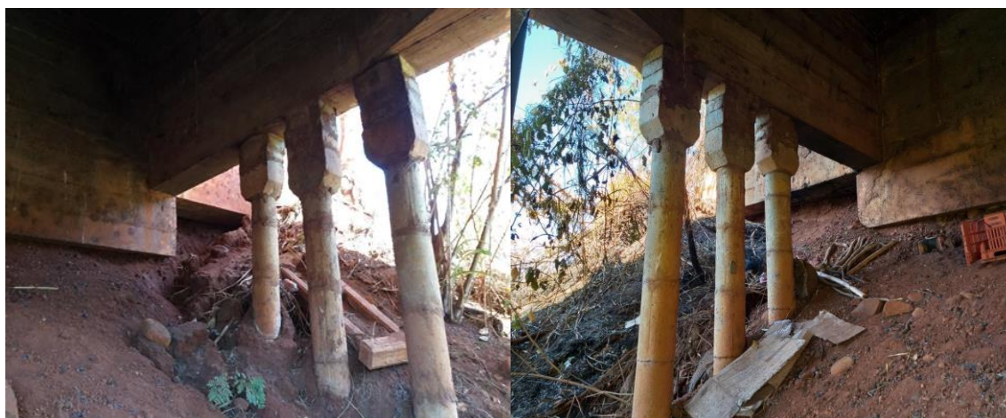
Figura 11 – Estacas Mega – Lado direito.
