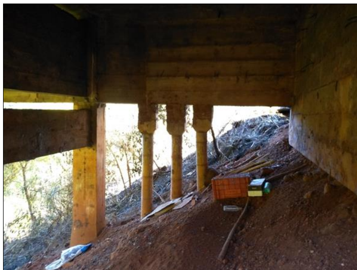
Figura 1 – Utilização de estacas Mega no balanço longitudinal da ponte.
