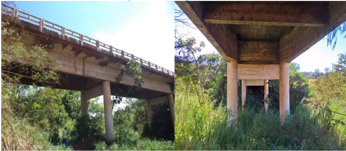
Figura 7 – Vista lateral da ponte.
