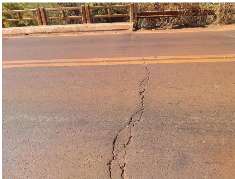
Figura 10 – Transição acesso-ponte.
