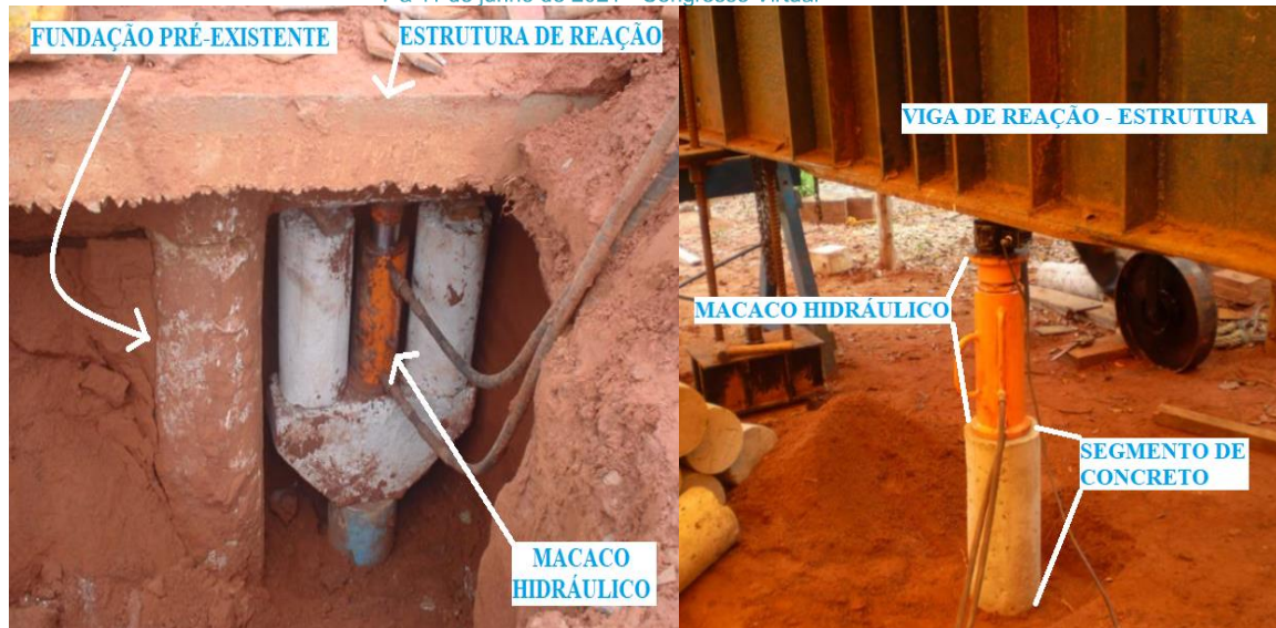
Figura 2 – Instalação de estaca-Mega (adaptado de Donadon (2009)).
